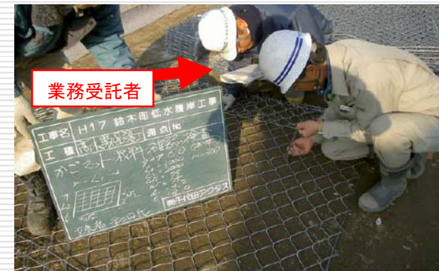
(河川護岸用かごマットの材料確認)
