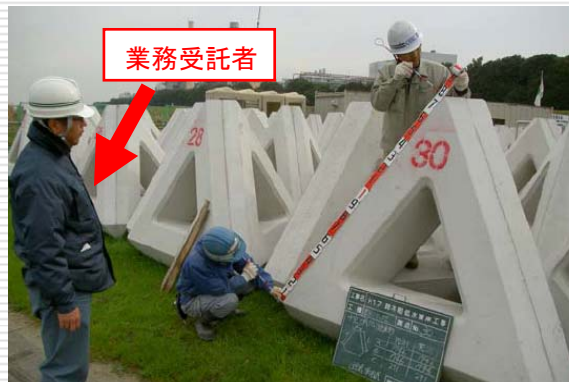
(根固めブロックの材料確認)
