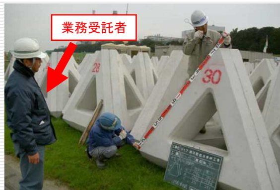
(根固めブロックの材料確認)
