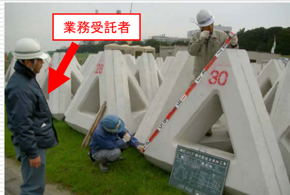
(根固めブロックの材料確認)
