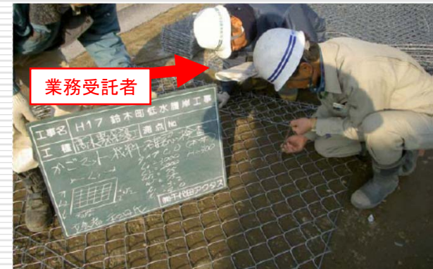
(河川護岸用かごマットの材料確認)
