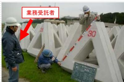
(根固めブロックの材料確認)
