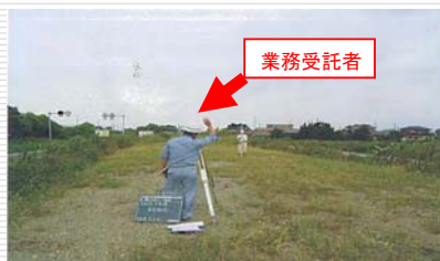
(現場状況の照合を実施)
