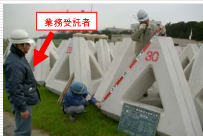
(根固めブロックの材料確認)
