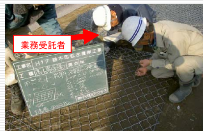
(河川護岸用かごマットの材料確認)
