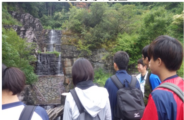
砂防堰堤の見学
