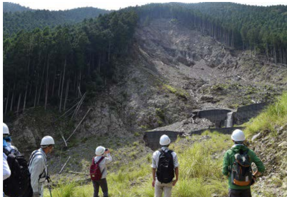
災害現場の調査
