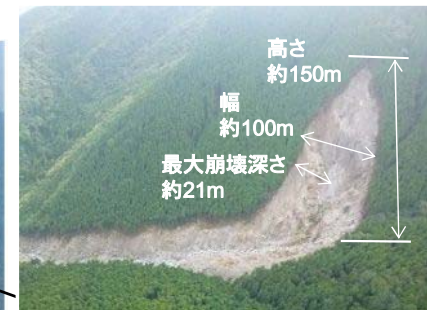
崩壊地の状況
