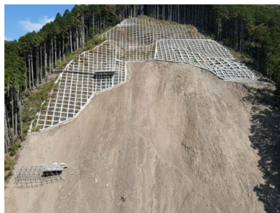
◆池ヶ谷法面对策工事(10月末の状況)
