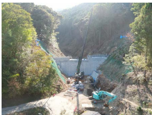
◆丁字ヶ谷左支堰堤工事(10月末の状況)
