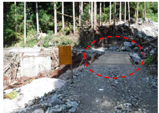
写真-1 小笠原様が住民の方と協力して設置した仮設橋
