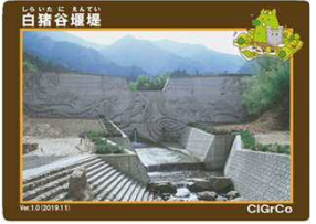
しらいたにえんじ 白猪谷堰堤 (愛媛県東温市河ノ内)
