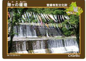
よけのえんじ 除ヶの堰堤 (愛媛県東温市山之内)
