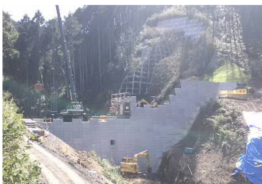
丁字ヶ谷第2号堰堤改良工事
