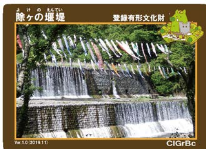
よけのえんてい 除ヶの堰堤 (愛媛県東温市山之内)
