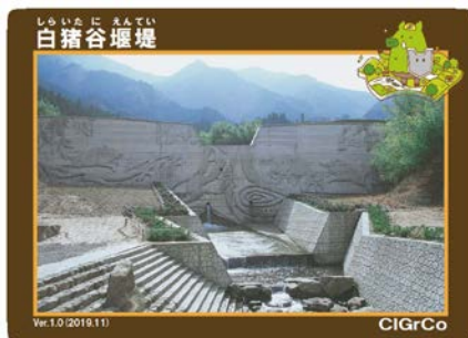
しらいたにえんてい 白猪谷堰堤 (愛媛県東温市河之内)
