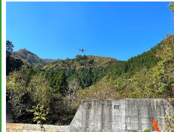
写真-4 UAVによる施設点検
