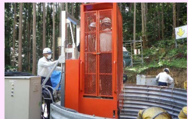
工事用エレベーターの見学
