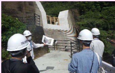
透過型に改良した砂防堰堤の見学
