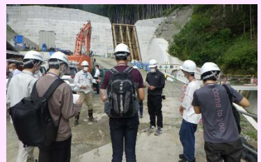
透過型砂防堰堤工事の見学
