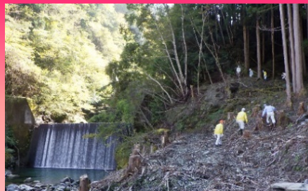
くまたに 熊谷第2堰堤
