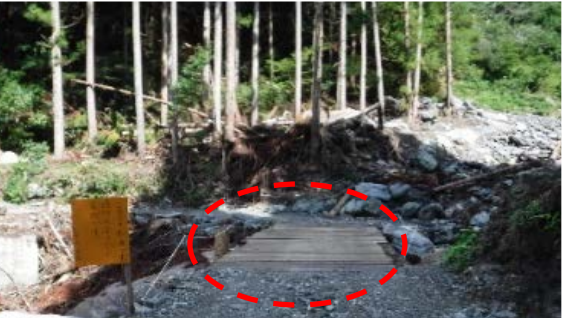
小笠原様が住民の方と協力して設置した仮設橋
