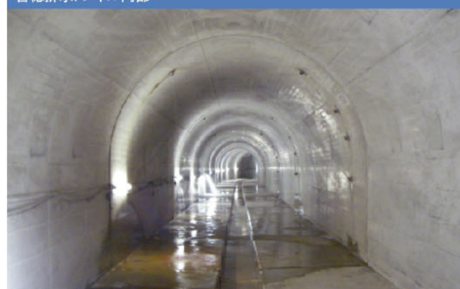
善徳排水トンネル内部
