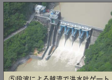
⑤段波による越流で洪水吐ゲート制御機器の機能不全
