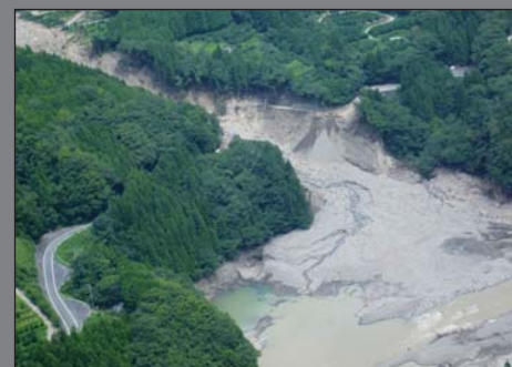
④寸断された国道493号
