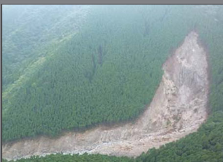
①崩壊源頭部
