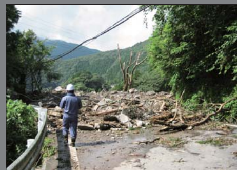
③国道493号の土砂堆積状況
