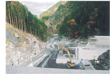
平成8年 第1副堤及び側壁施工状況
