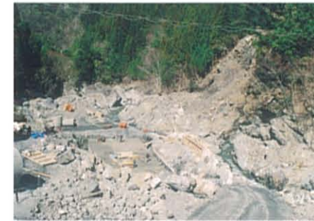
平成3年 本堤基礎施工状況(本堤上流より望む)
