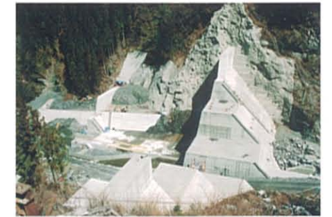
平成8年 本堤・第1副堤・第2副堤を左岸側から望む
