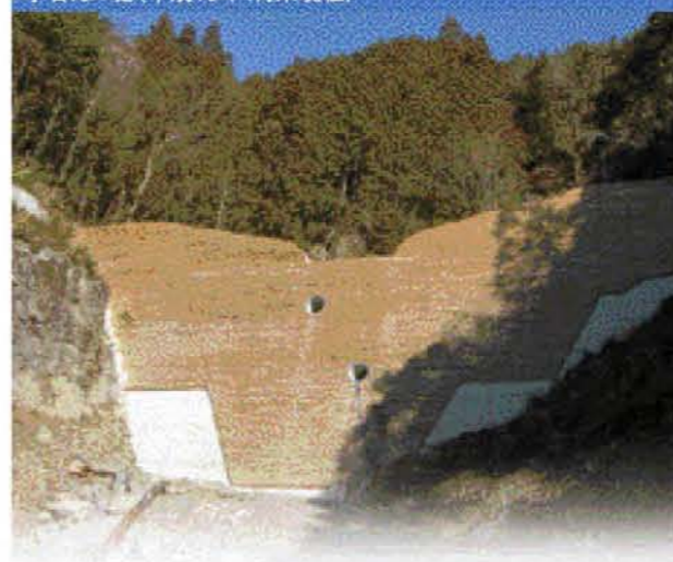
水谷えん堤(平成19年1月末現在)
