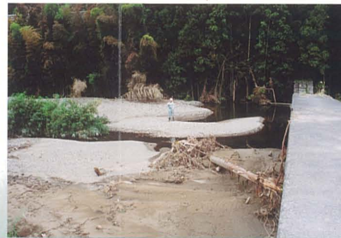
② 土石流を捕捉し満砂した日浦第2堰堤（表川）
