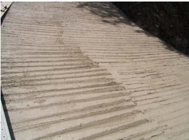
② コンクリート舗装部の凹凸
