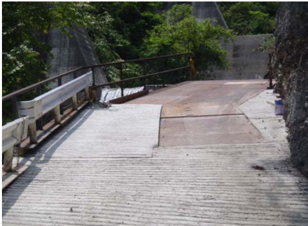
② コンクリート舗装部の凹凸
