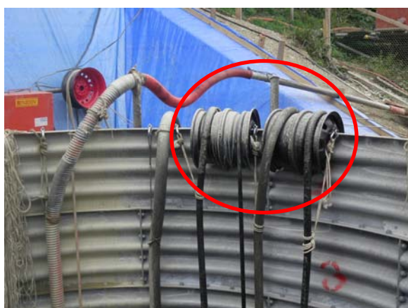
油圧ホース、キャプタイヤ等、ライナープレートの接触箇所防護用金具
