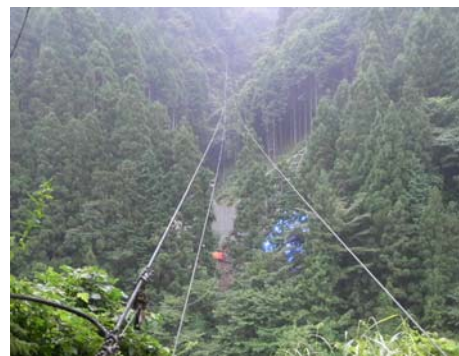
写真1(ケーブルクレーン)
