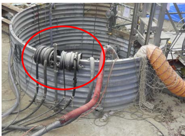
油圧ホース、キャプタイヤ等、ライナープレートの接触箇所防護用金具
