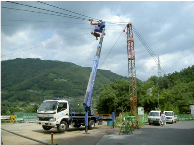
(1)-2ケーブルクレーンの点検
