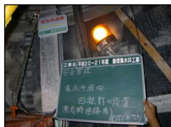
写真3 パトライト(回転等)設置状況
