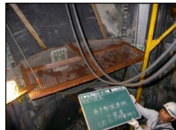
写真1 落下物保護網設置
