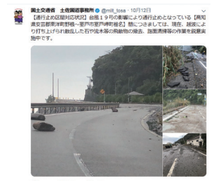
令和元年10月12日 国道55号 高知県安芸郡東洋町～ 室戸市室戸岬町通行止め状況
