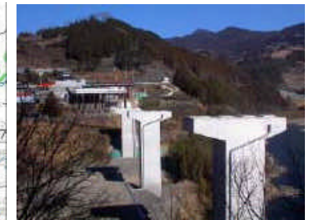
越知道路(工事中)
