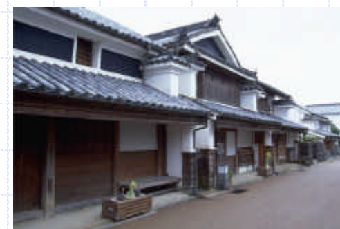
景観に配慮された道
