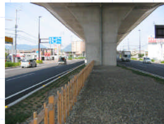
中央分離帯に設置された木製 横断防止柵（高松市）
