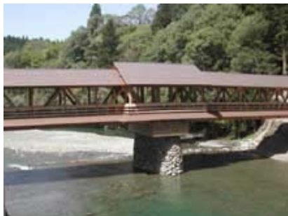
神幸橋 (屋根付木橋)
