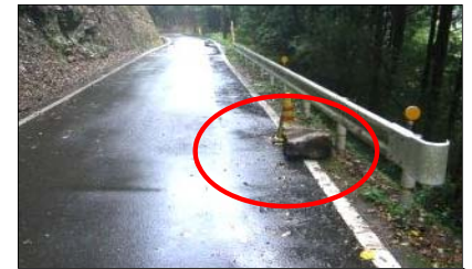
国道493号落石状況
