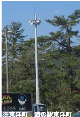
<実施箇所> 東洋町、北川村
