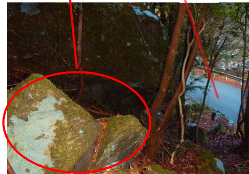
写真① 防災上危険な箇所
