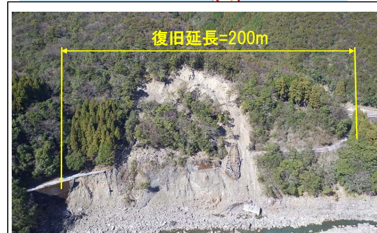
平成26年8月豪雨による大規模地すべりの状況(北川村小島地区)
