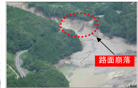
国道493号被災状況
