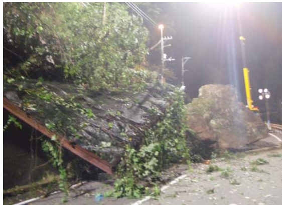
平成22年 岩盤崩壊状況
