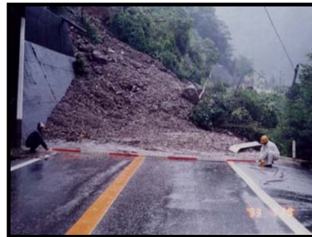
写真①【平成5年 土砂崩壊状況】
