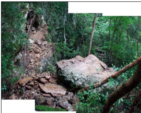
写真①【亀裂が発達し、剥離した岩塊】
