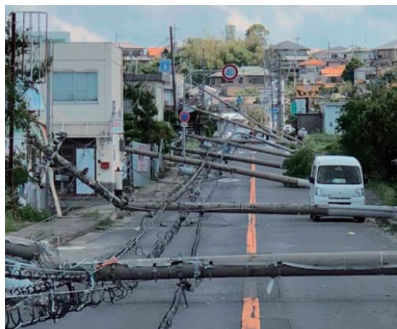
平成30年 台風21号による大阪府泉南市の被災状況
