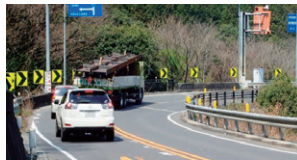
写真②:高知側線形不良箇所
