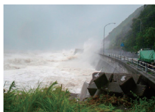
国道55号 越波状況
