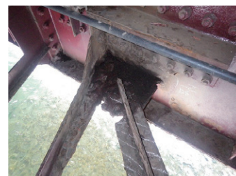
老朽化により損傷の著しい橋梁(左:大川橋(香川県)、右:津島大橋(愛媛県))
