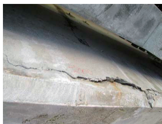
老朽化により損傷の著しい橋梁(左:大川橋(香川県)、右:津島大橋(愛媛県))
