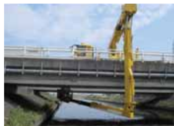
点検車による点検
