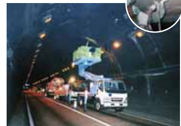
構造物の補修
