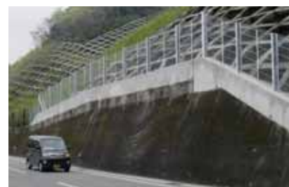
法面対策(法枠工)
