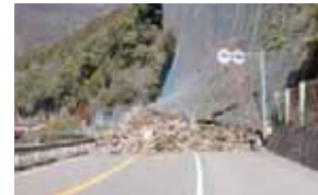
H23.2.26 土砂崩壊による災害 高知県仁淀川町
