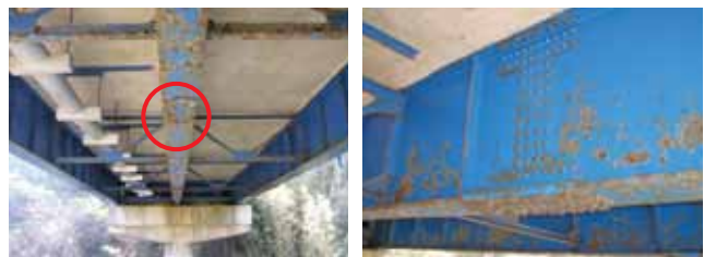
高齢化により損傷の著しい橋梁(高知県：相間川橋、1967年架設)
