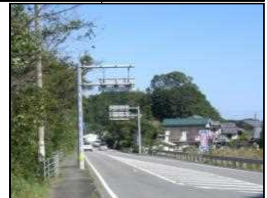
〈国道55号 海陽町 浅川付近〉
