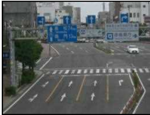
〈国道11号 徳島市 徳島県庁交差点付近〉
