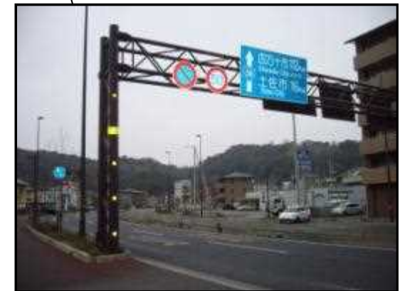
〈国道56号 高知市 筆山付近〉
