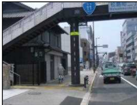
〈国道11号 高松市 松島2丁目付近〉
