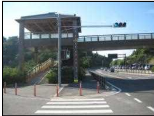
〈国道196号「道の駅」風和里付近〉
