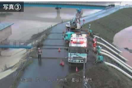
大洲道路を走行し駆けつけた排水ポンプ車で排水作業
