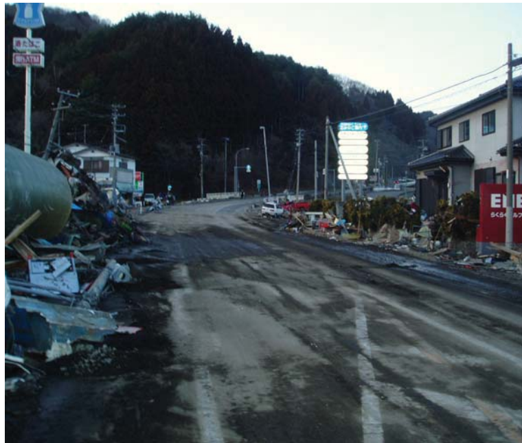
▲啓開作業後(釜石市市街地方面を撮影)
