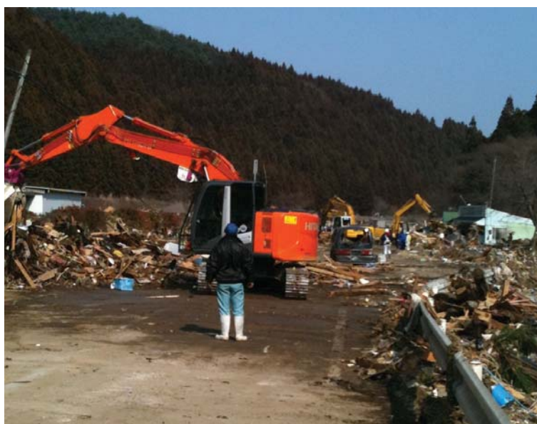
▲啓開作業中(南三陸町戸倉地区を撮影)
