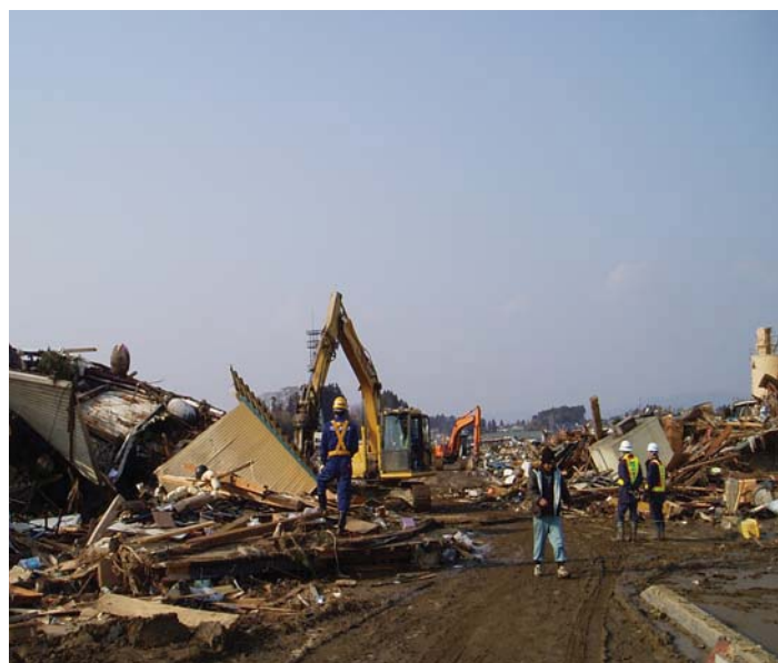
▲啓開作業中(気仙沼市最知地区を撮影)
