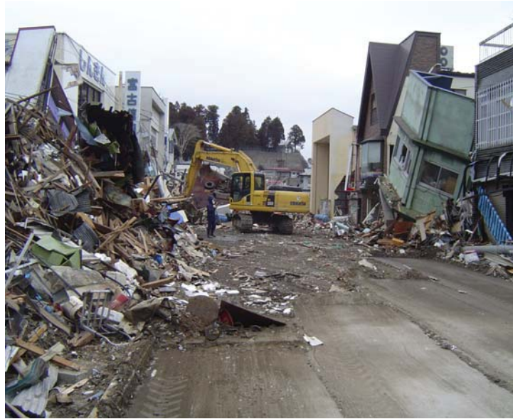
▲啓開作業中(岩手県山田町内を撮影)
