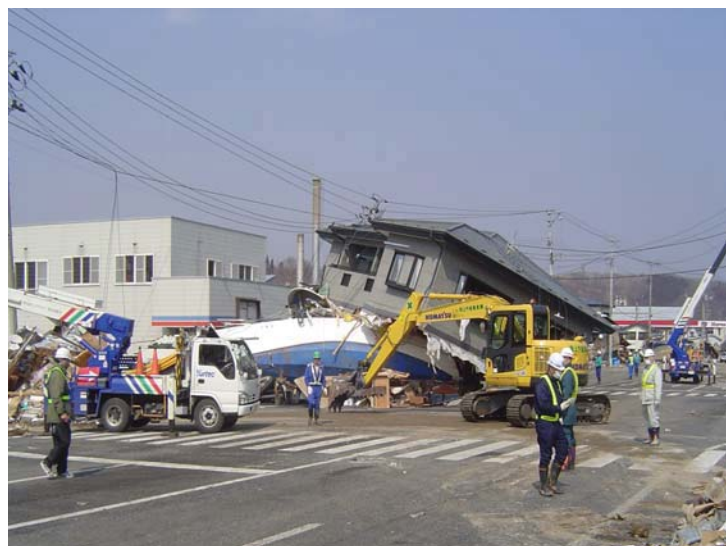
▲啓開作業中(宮古市市街地を撮影)
