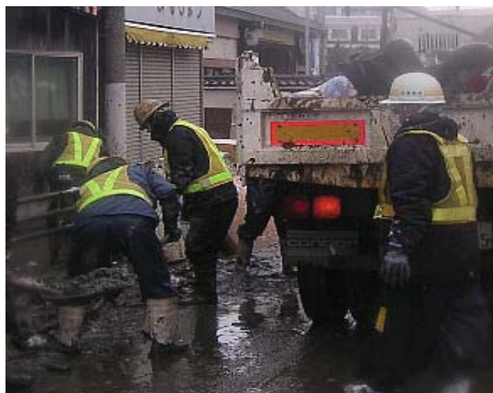
▲啓開作業中(松島町松島地区を撮影)
