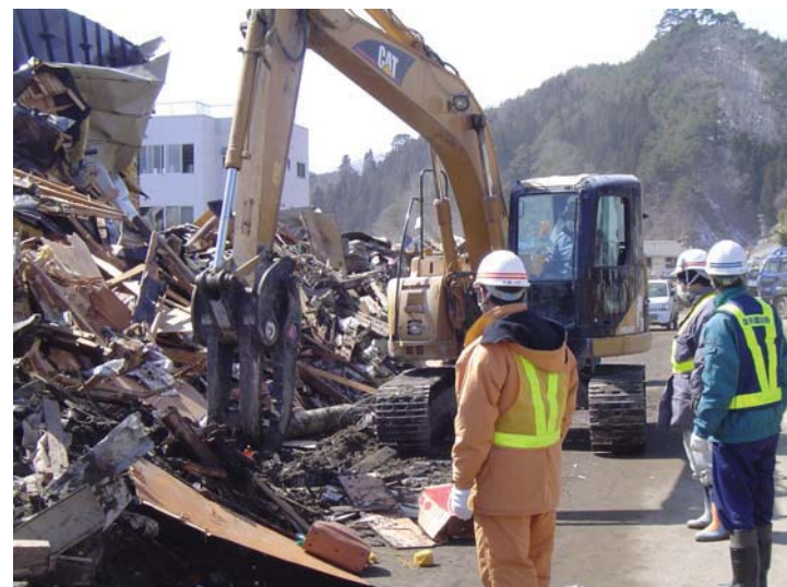
▲啓開作業中(宮古市田老町地区を撮影)
