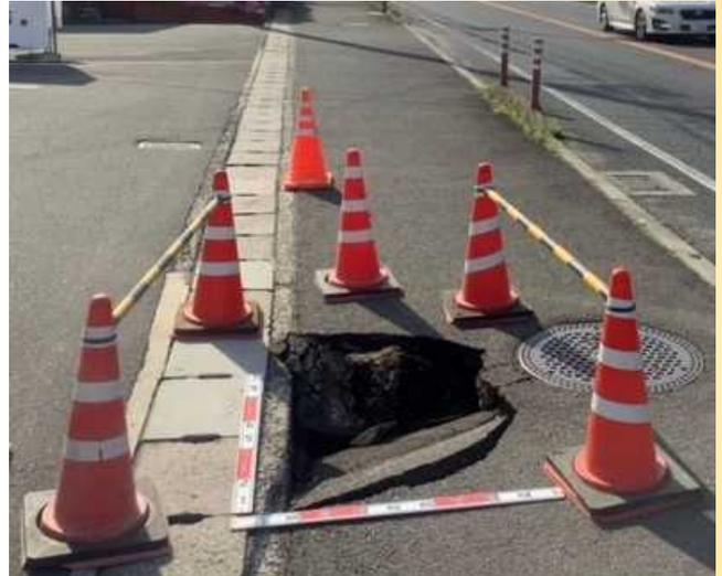
地下埋設物に起因する歩道の陥没
