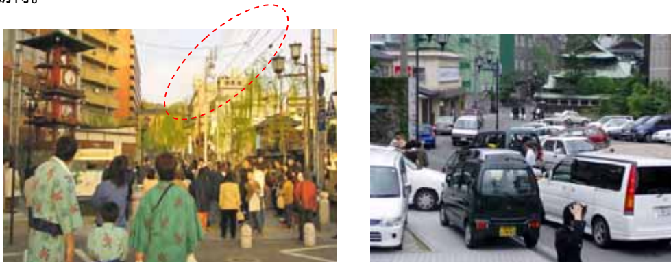
写真 - 13 道後温泉地区無電柱化未整備区間の現況
