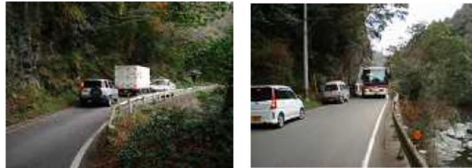
写真 - 5 交通隘路の状況
