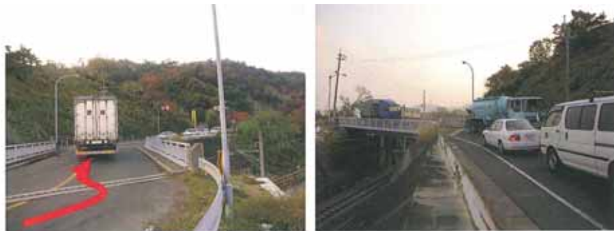
写真 - 10 国際コンテナ通行支障区間（線形不良）の状況
