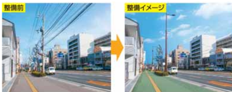
写真 - 4 電線共同溝整備イメージ
