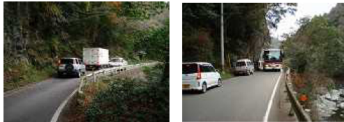
写真 - 5 交通隘路の状況
