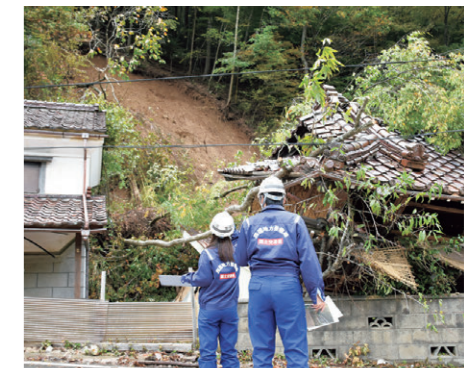
被災状況調査 (土砂災害)
