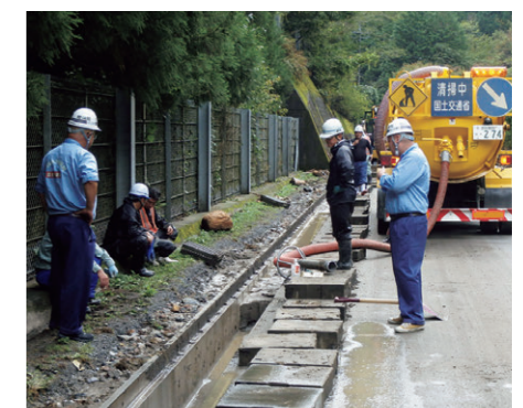
応急対策 (路面清掃)
