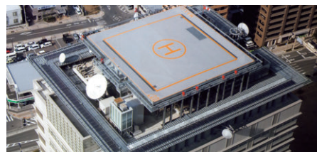
屋上ヘリポート
