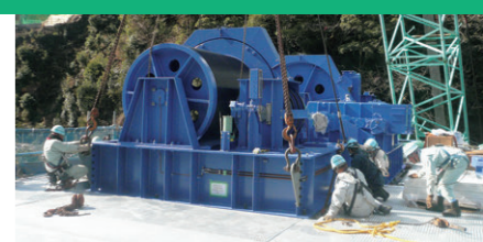
ダム放流設備の閉開装置据付
