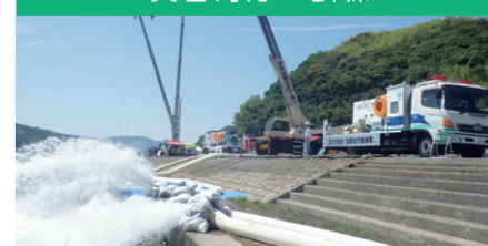
災害対策用機械操作訓練
