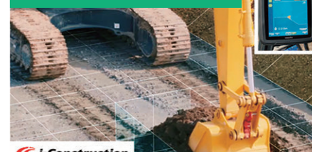
ICT建機による施工
